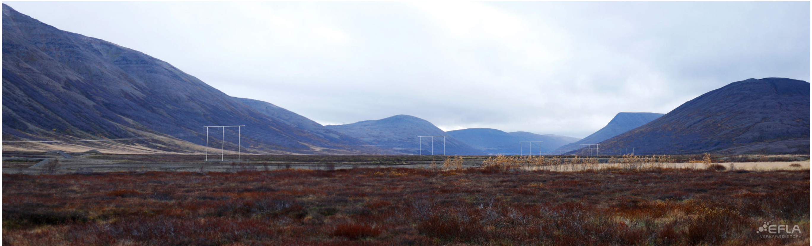
MYND FN-8.3 Frá Reykjum í Fnjóskadal, horft í suð austur. Tvírása mastur með láréttri uppröðun, röramastur
